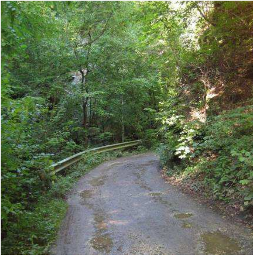
Talaufwärts geht es jetzt auf einem breiteren und befahrbaren Waldweg...
