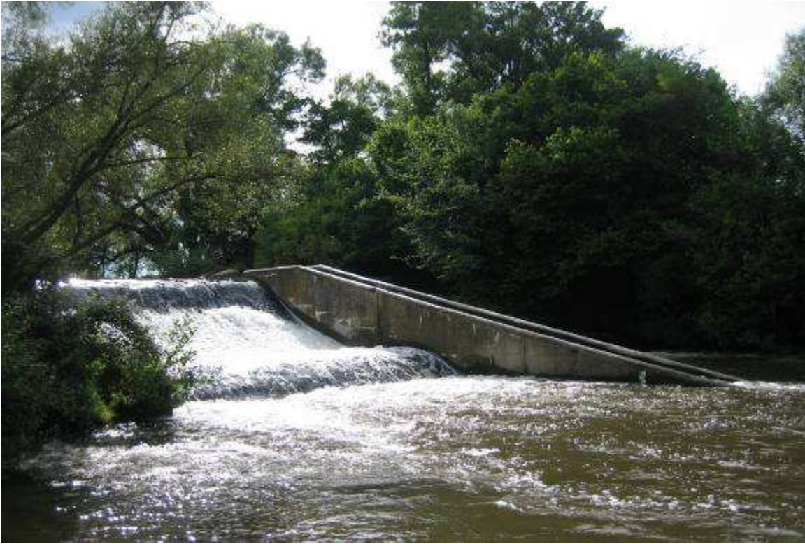
Man kommt an einer Fischtreppe an diesem Wehr vorbei.
