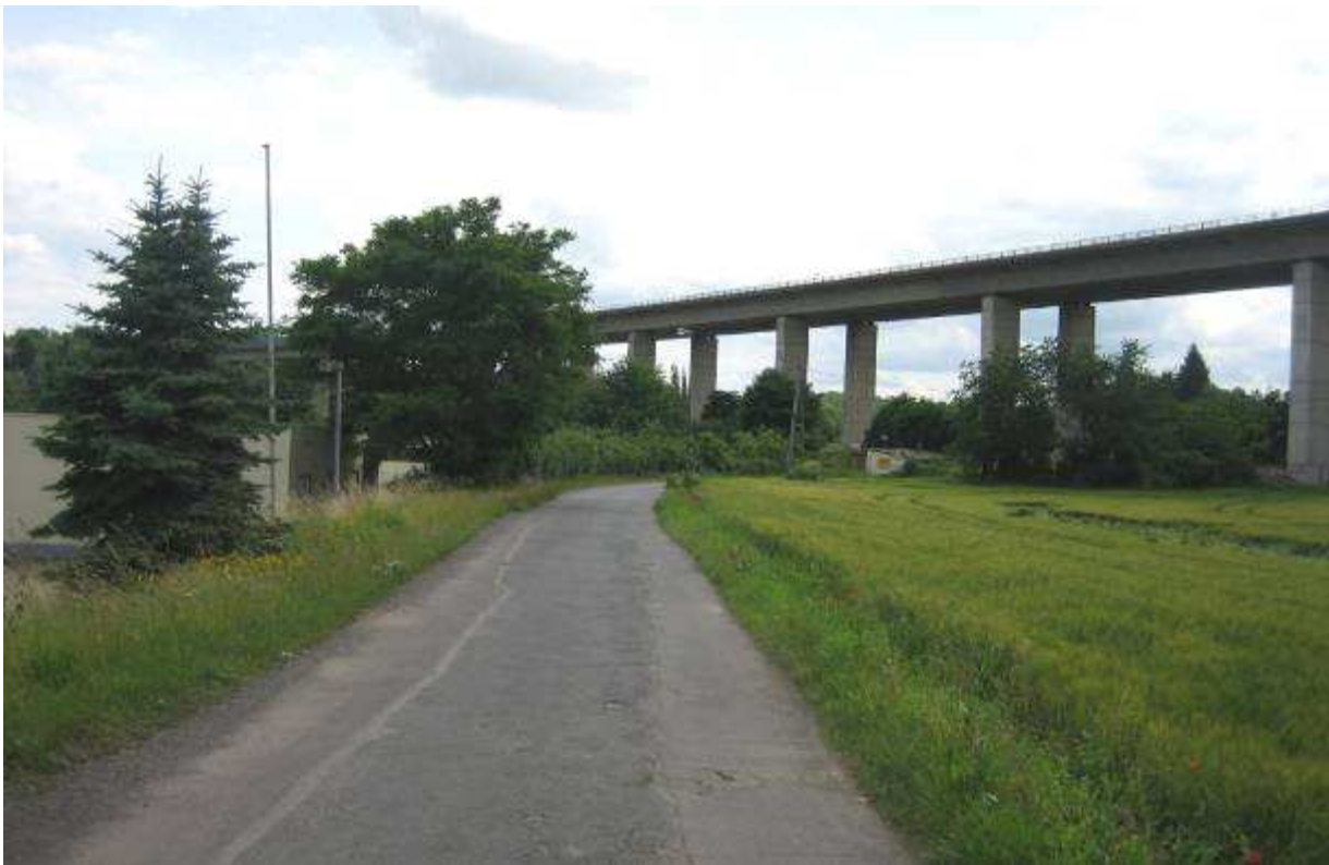
Der mittlerweile geteerte Weg führt unter dieser Autobahnbrücke hindurch...
